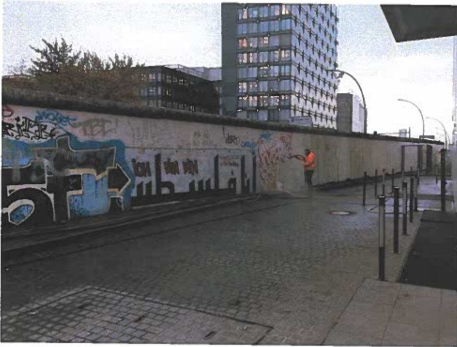
Frühjahr 2017, Reinigung und Rissanierung der East Side Gallery
