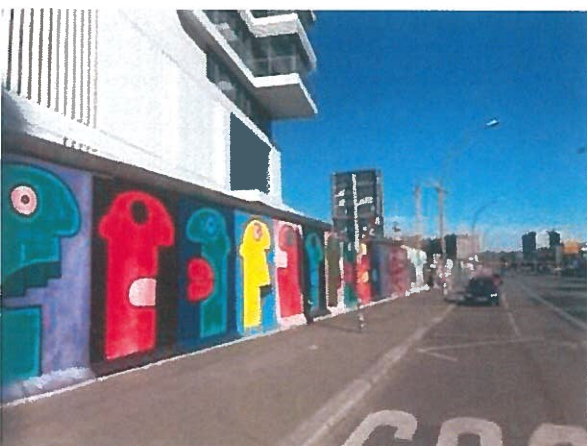
G - Die Straßenseite der East Side Gallery nach der Reinigung (Sondernutzungsrecht der Stiftung)
