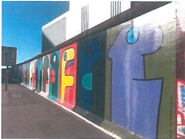
A - Die Straßenseite der East Side Gallery nach der Reinigung (Sondernutzungsrecht der Stiftung)
